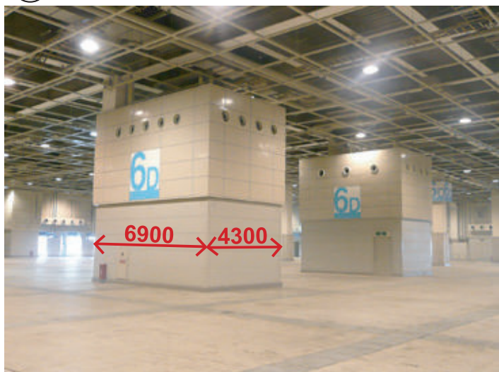
④ 非常階段 Emergency staircase
